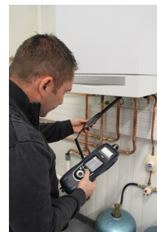
Vérification CO ambiant
