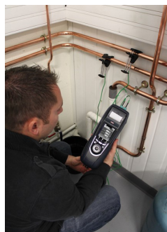
Température réseau ECS
